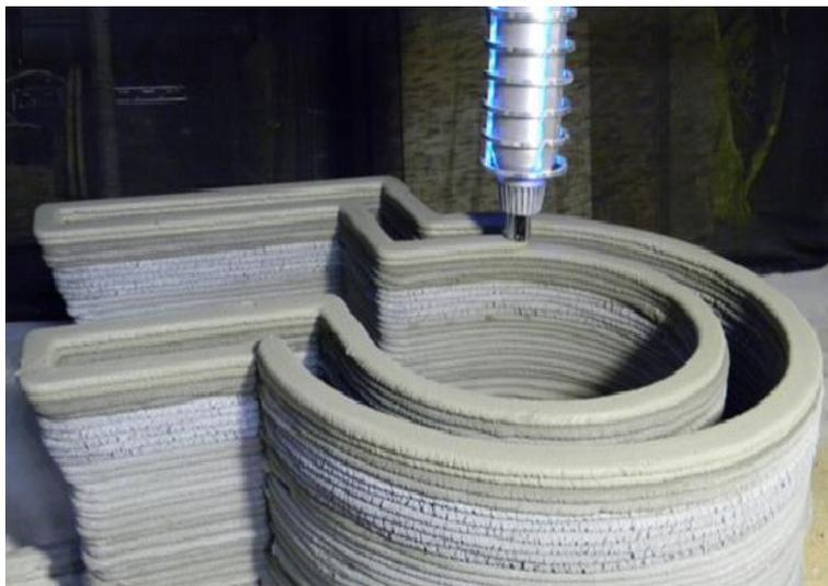
Рис. 2. Изготовление конструкции сооружения методом послойного экструдирования
