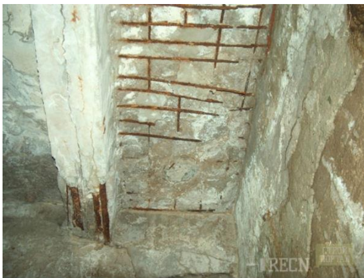
Рисунок 1, рисунок 2 . Отображают коррозию бетона и стальной арматуры в железобетонных конструкциях.
