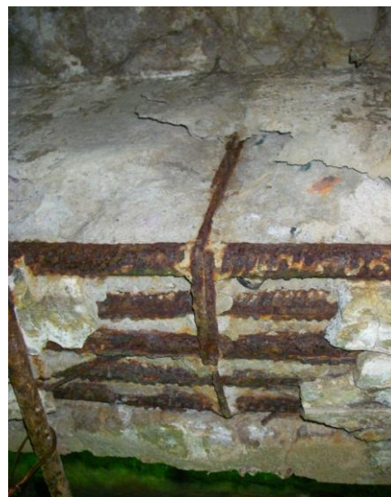
Рисунок 1, рисунок 2 . Отображают коррозию бетона и стальной арматуры в железобетонных конструкциях.
